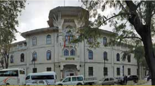
Sultanahmet Meydanı'nda bulunan ve Marmara Üniversitesi Rektörlüğü'nün kullandığı bina, Osmanlı'nın Ticaret ve Ziraat Nezareti binası idi. Giriş kapısı üzerindeki Ticaret ve Ziraat Nezareti yazısı hâlâ duruyor.
